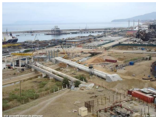
Ø 2000 mm: Skikda (Algérie) Portée libre 26m Essai pression: 6b
