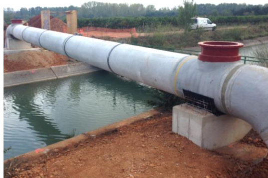
Ø 800mm : CNM Nîmes Costières Portée libre 15,6 m Essai pression: 10b
